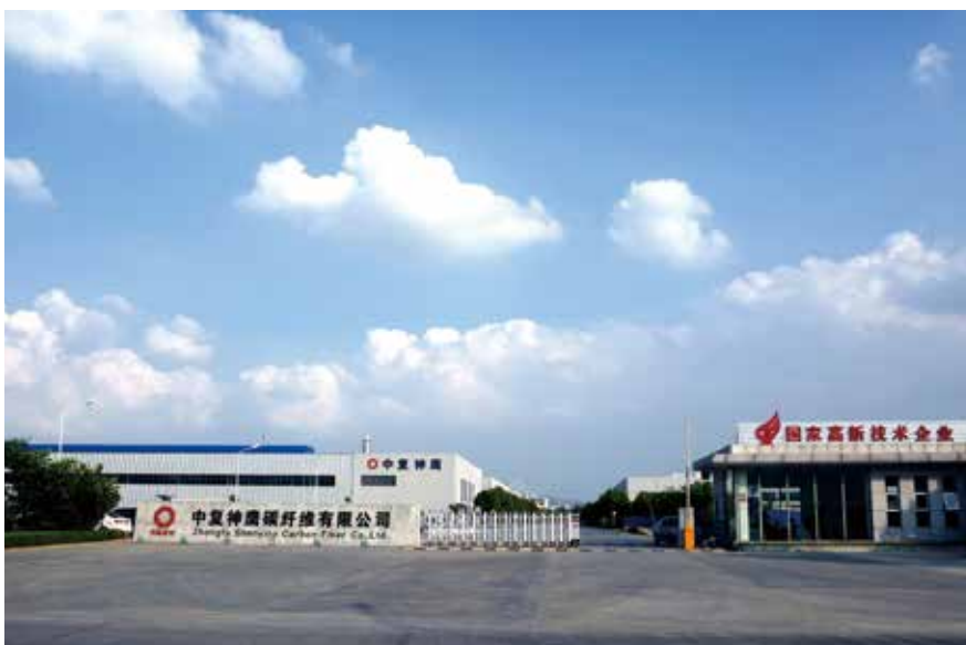
2008年建成千吨级SYT35（T300级）碳纤维生产线
